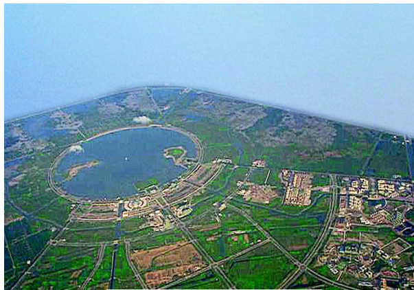
吹填疏浚工程
