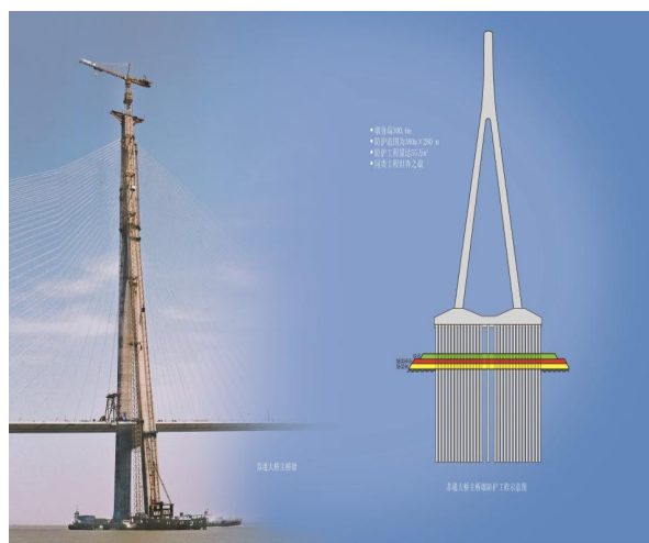
桥墩防护工程
